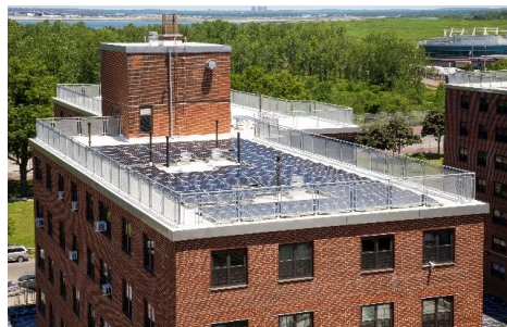
Techo reparado y sistema de paneles solares en Ocean Bay (Bayside)
