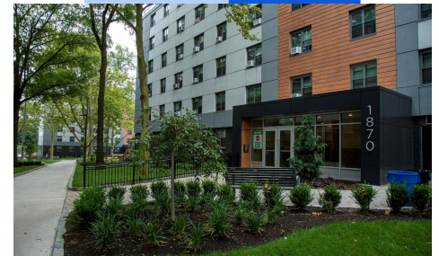
Adecuación de los terrenos de Armstrong y Baychester.
